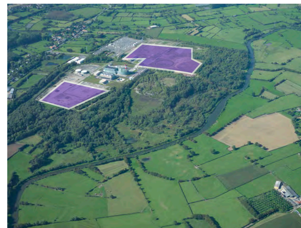
Vue oblique depuis le Nord-Est du site
