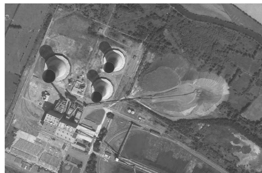
La centrale en 1983 présentait encore l'ensemble des cheminées.
